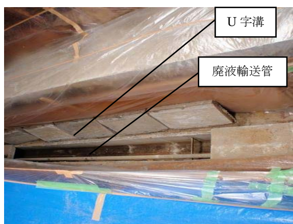
写真 2.3.2-1 廃液輸送管敷設状況
